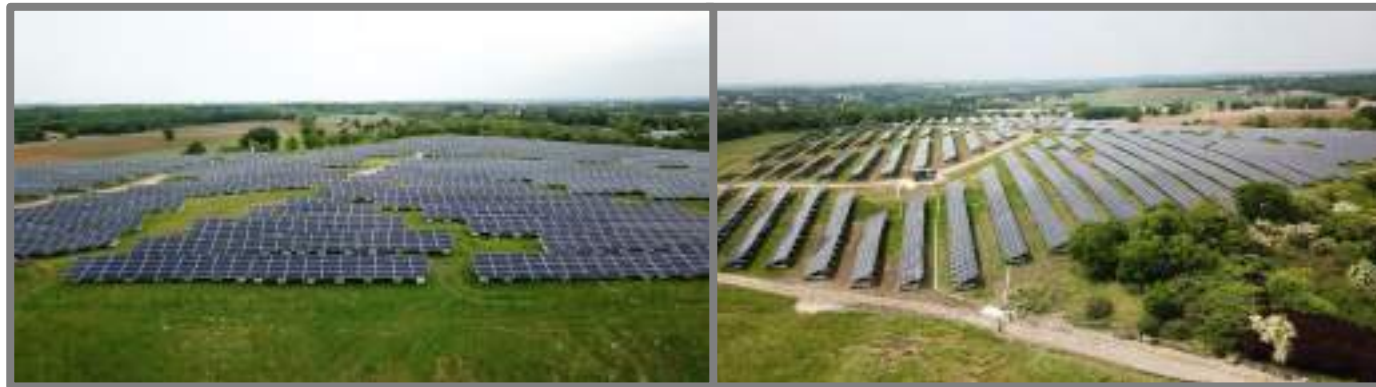
Figure II-14 : Parc solaire e l'ancienne ISDND de Couronne
