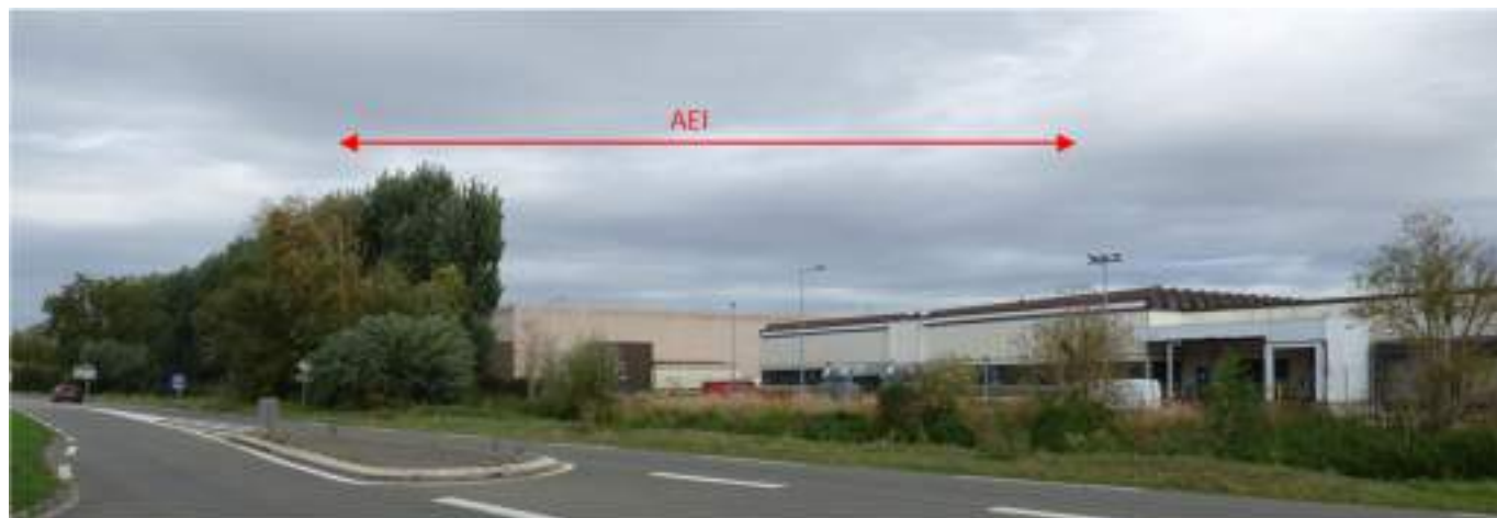
Photographie III-5 : Vue 5-Ouest du site, depuis le lotissement le plus proche de l'AEI
