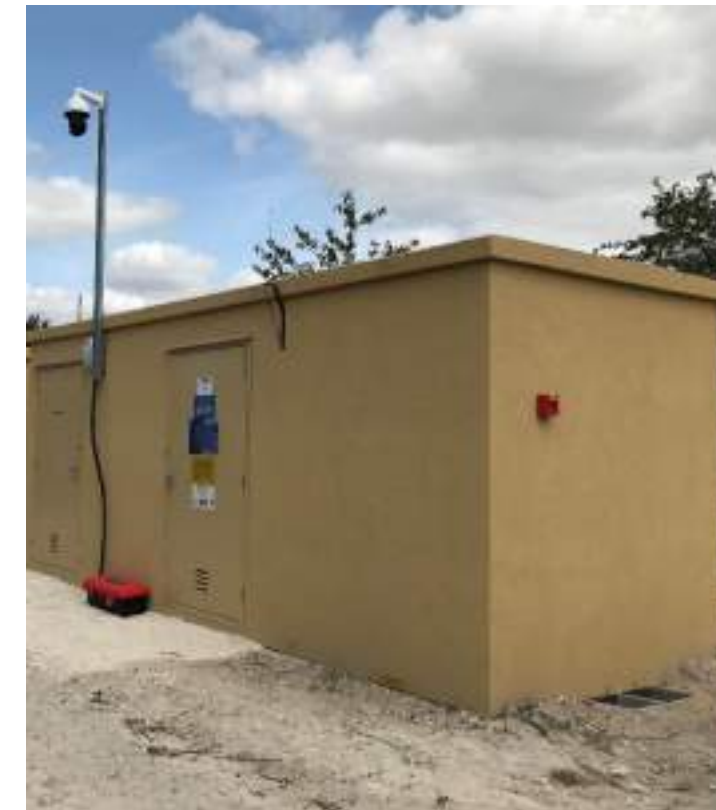
Photographie II-4: Exemple de poste électrique préfabriqué – source CVE
